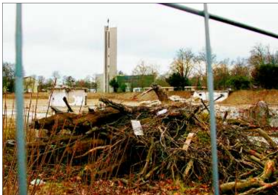
Im Frühjahr wird mit der Neubebauung des Europaplatzes begonnen.
